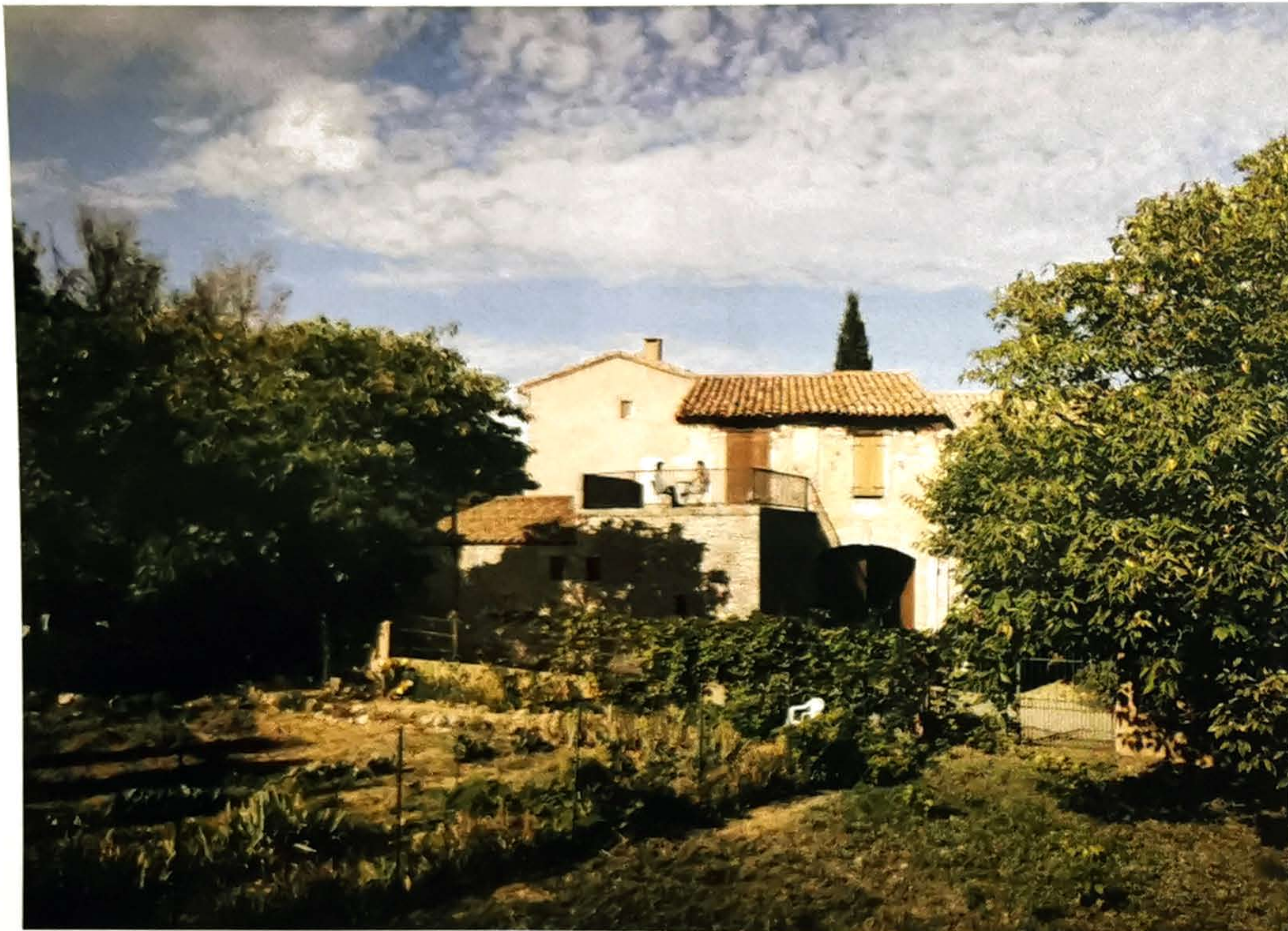
Vue depuis la parcelle AN 220, après travaux
