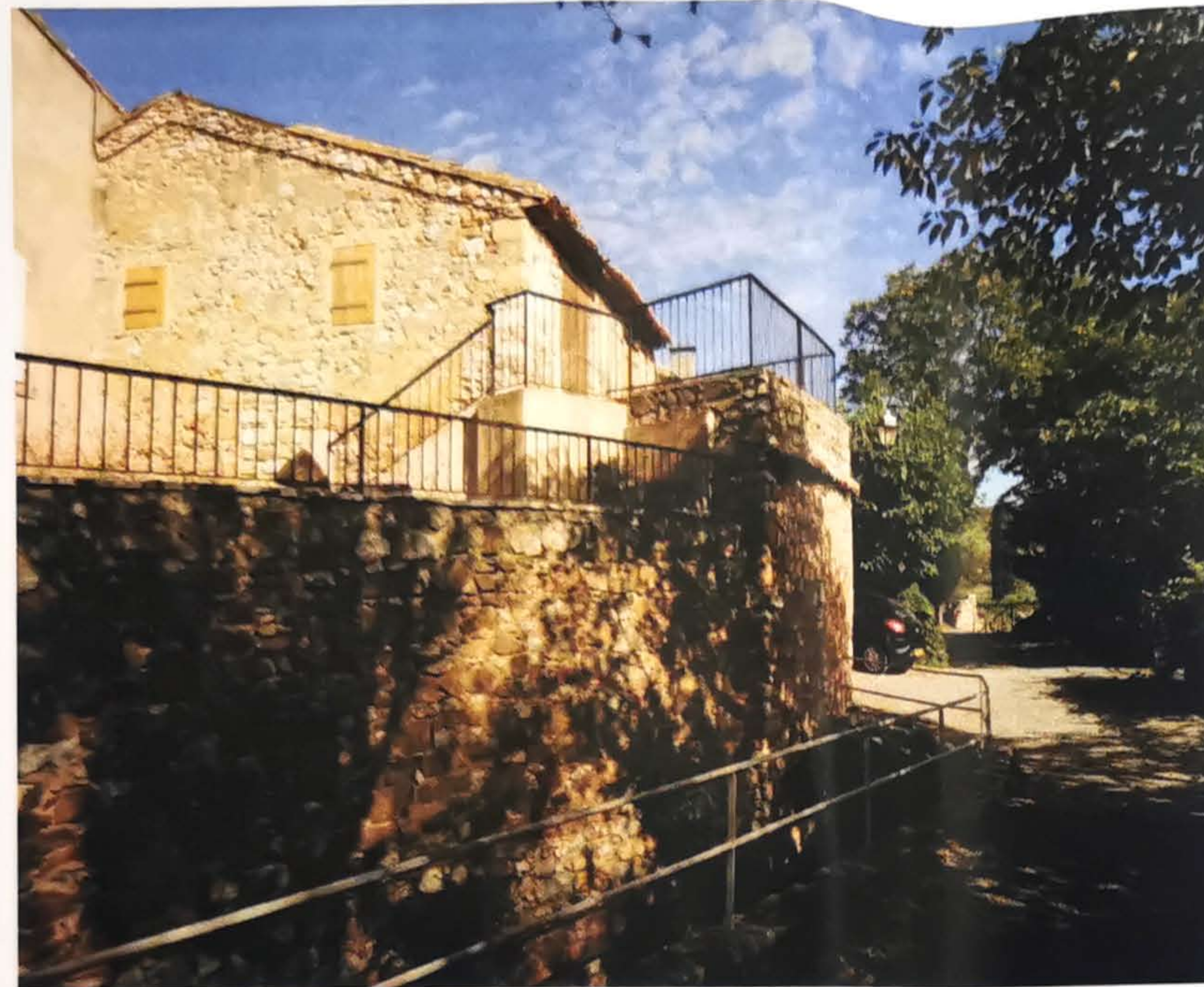
2 - Vue du mur d'enceinte à conserver
