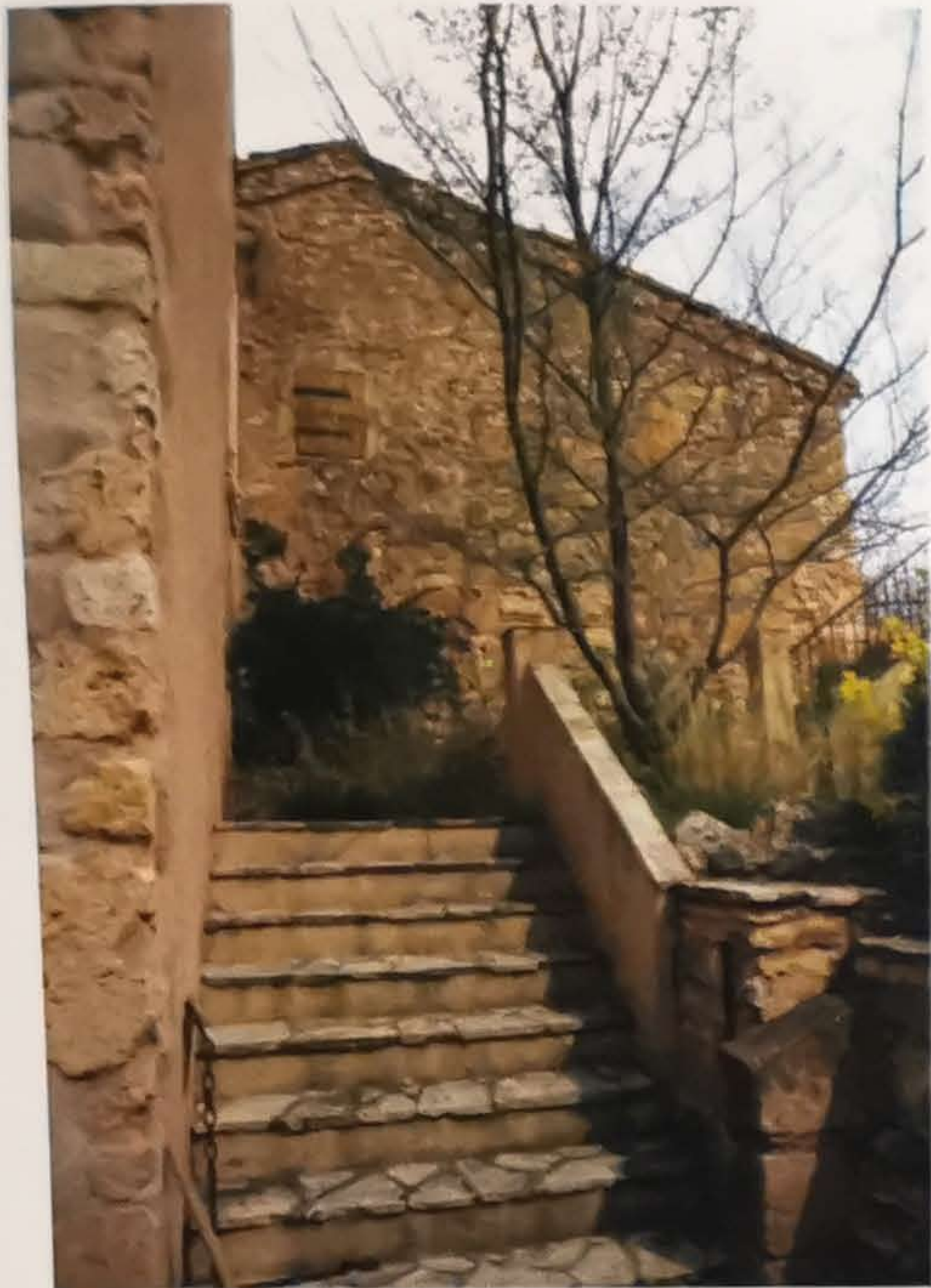
1 - Vue de l'escalier existant
