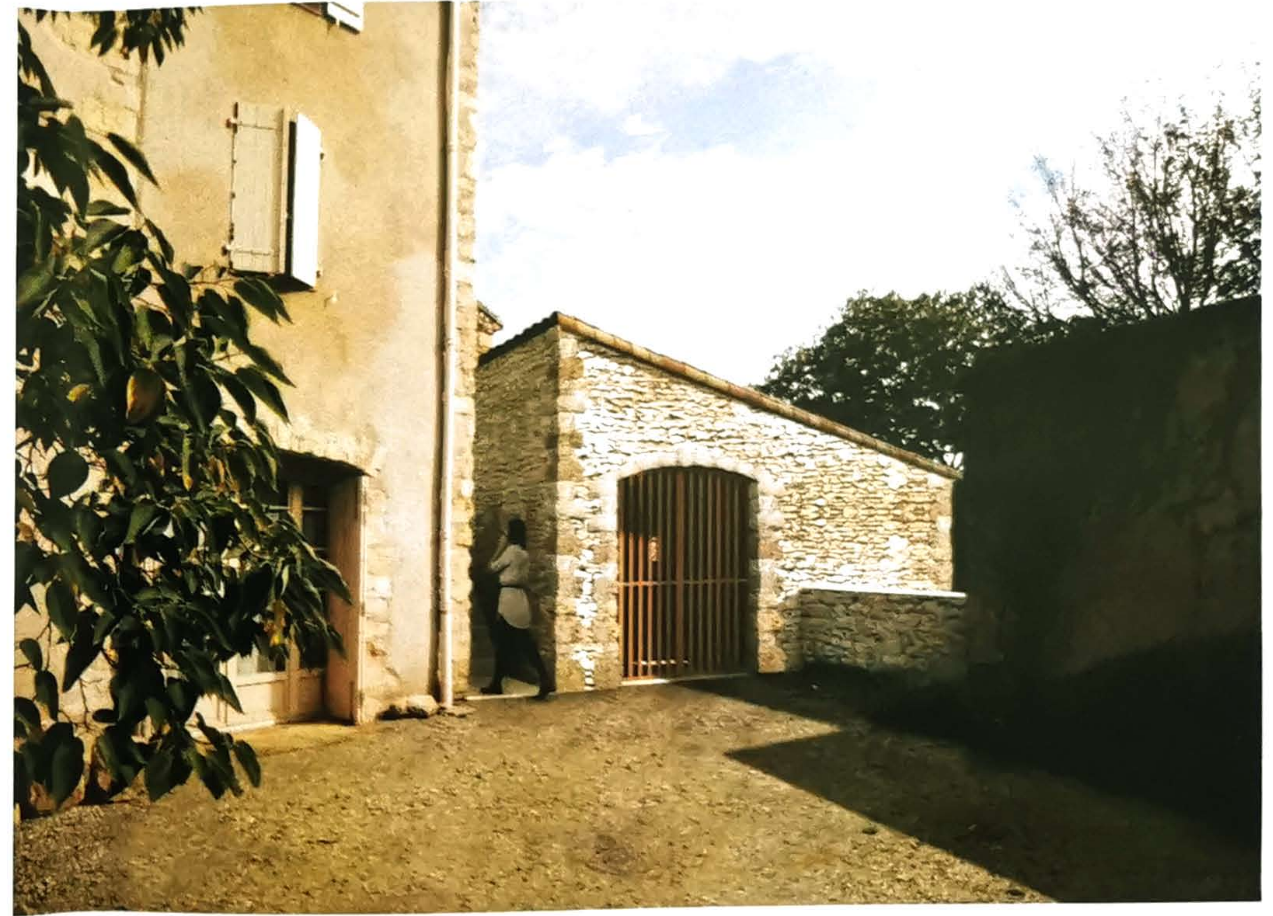
Vue depuis la place Saint-Laurent, après travaux
